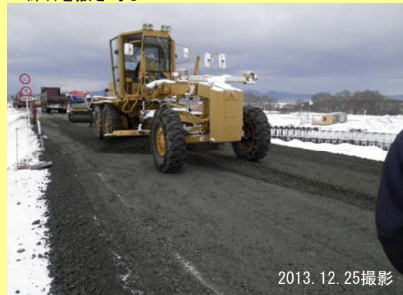
砕石を敷き均し
