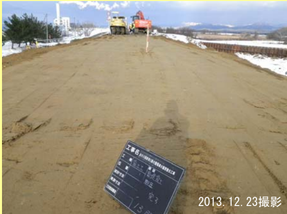
堤防の盛土完成！
