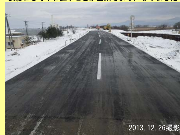
舗装をして車を通すことが出来るようになりました！
